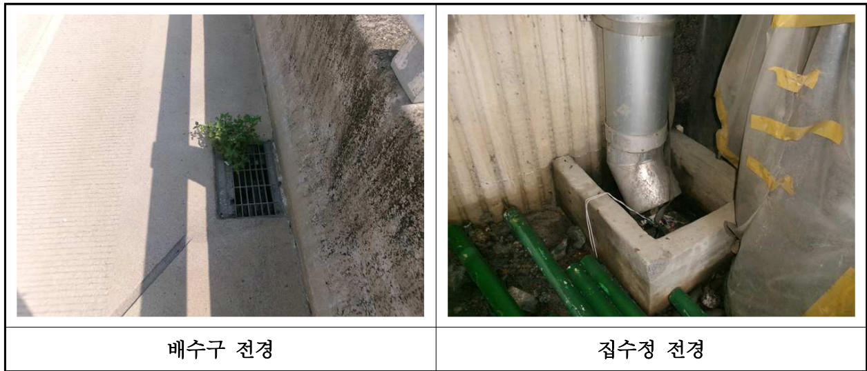
【사진 3.5.15】 배수시설 전경
