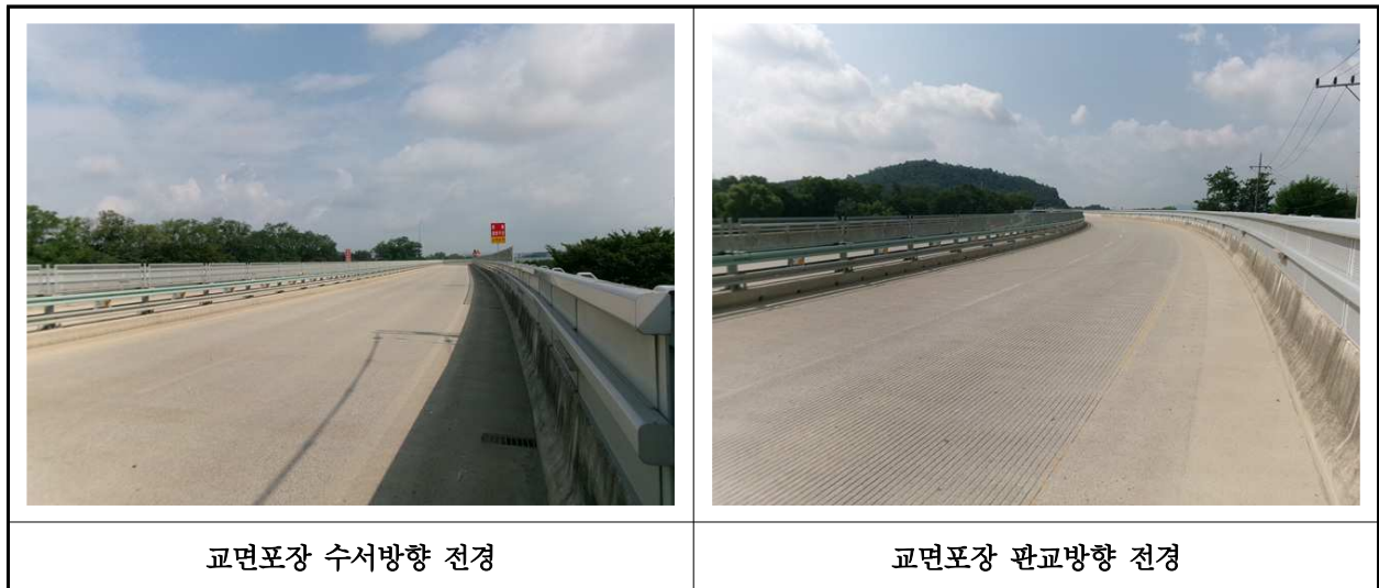
【사진 3.5.13】 교면포장 전경
