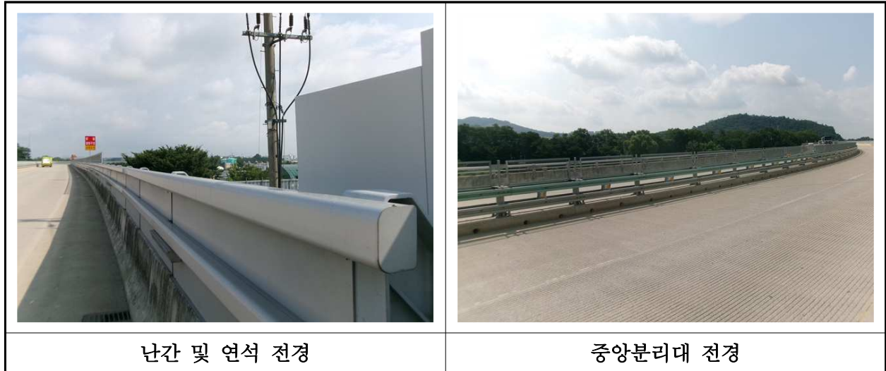
【사진 3.5.17】 난간 및 연석 전경
