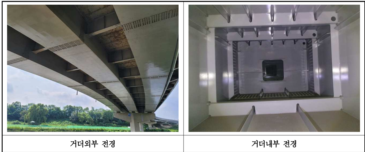
【사진 3.5.3】 거더 전경
