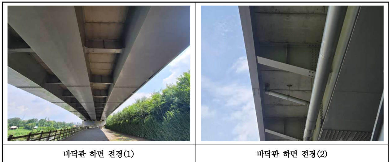
【사진 3.5.1】 바닥판 하면 전경
