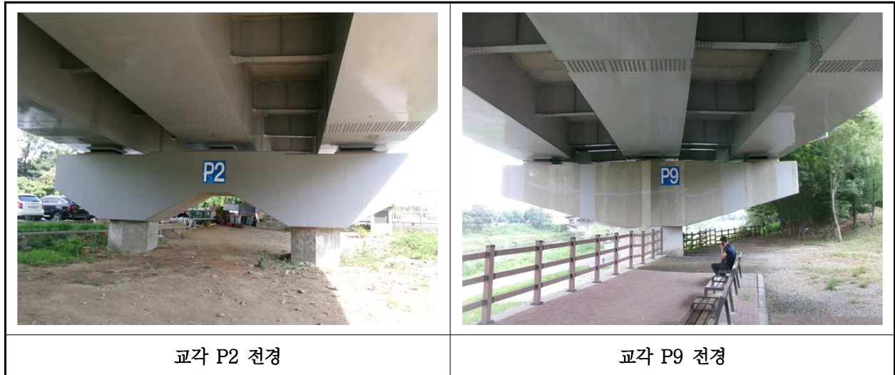
【사진 3.5.7】 교각 전경
